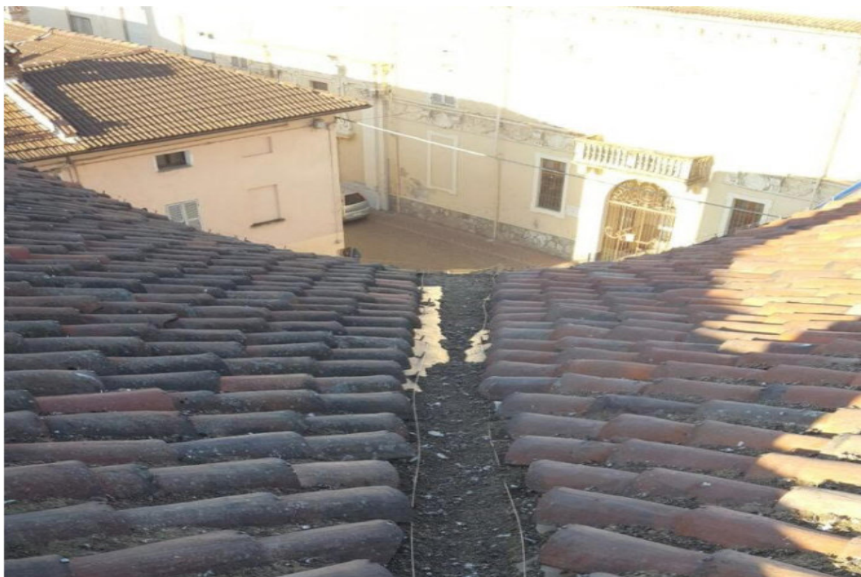
PARTICOLARE DEL DEPOSITO DI GUANO SULLA COPERTURA
