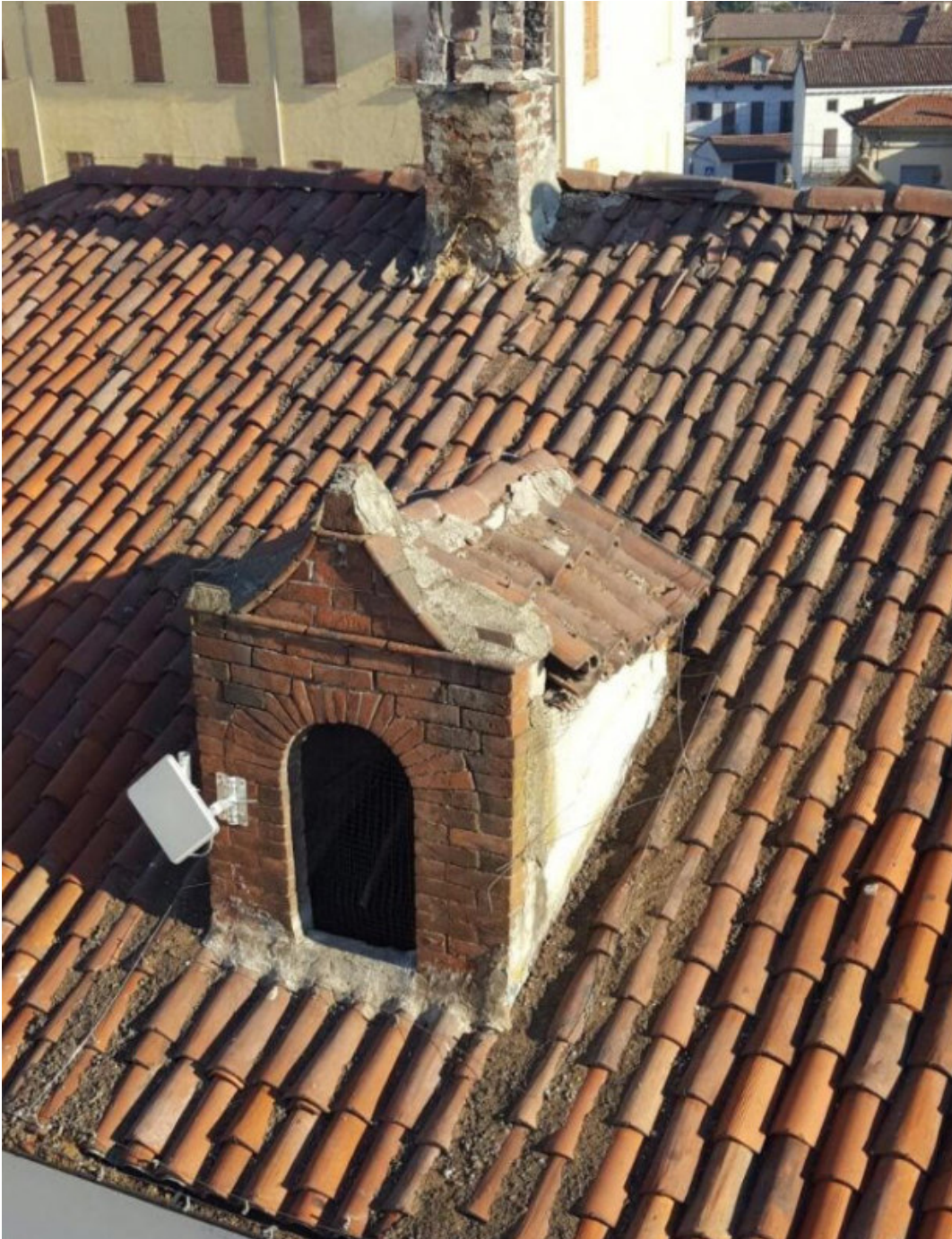
PARTICOLARE DEL DEPOSITO DI GUANO SULLA COPERTURA
